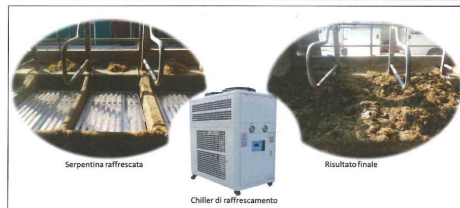
Figura 2 – Tre immagini dell'impianto di raffreddamento delle cuccette oggetto di ricerca - Operazione 16.2.01 PSR Emilia-Romagna - Progetto Filiera F37 (Bando DGR 227 /2017 e s.m.i.).
