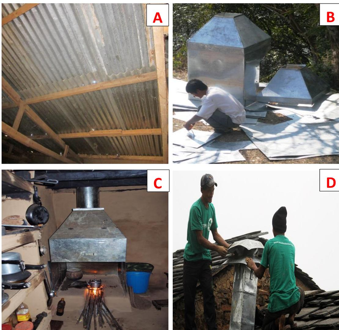
Figura 3. Assemblamento delle lamine (A) necessarie per la realizzazione della cappa (B-C) e del camino per lo scarico dei fumi (D)
