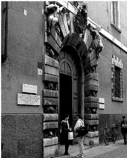
L'ingresso della Cattolica, in via Trieste
