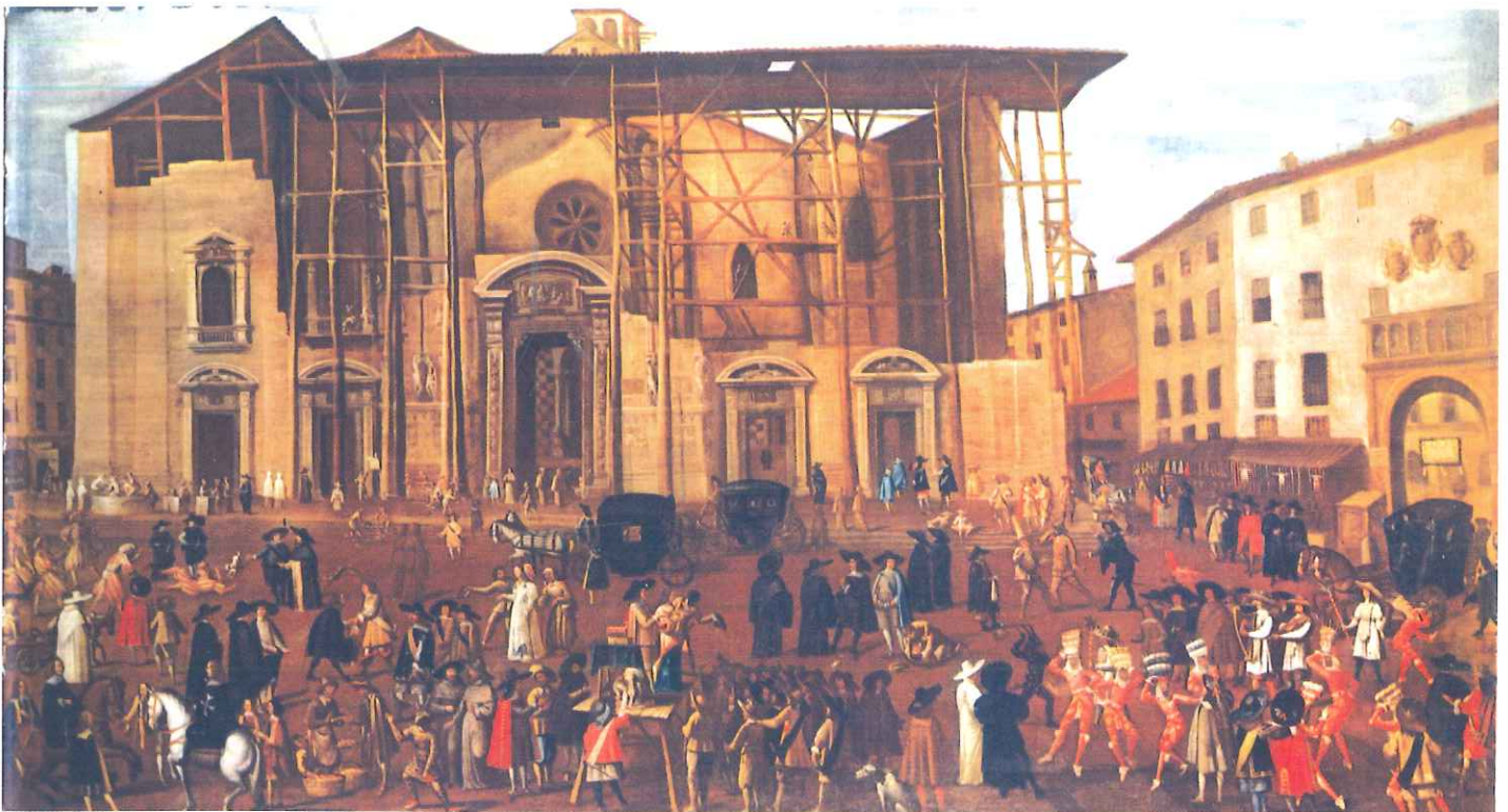
Fig. 6. La facciata del Duomo in costruzione durante la carnevalata del 1683 con Santa Maria Maggiore ancora visibile dietro i ponteggi.
